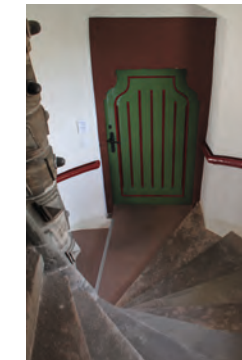
links: Die Rathaus-Treppe 1950 rechts: die Treppe heute
